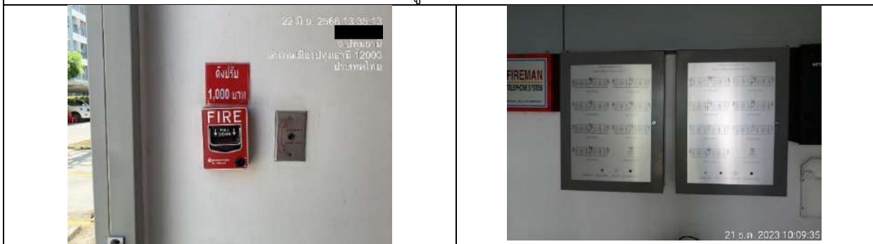
ชุดกดแจ้งเหตุแบบใช้มือและโทรศัพท์แจ้งเหตุเพลิงไหม้
