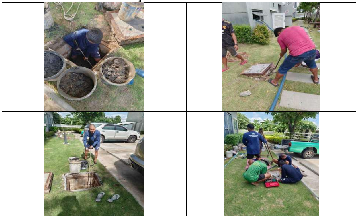
รูปที่ 2-8 การขุดลอกท่อระบายน้ำและบ่อบำบัดน้ำภายในโครงการ
