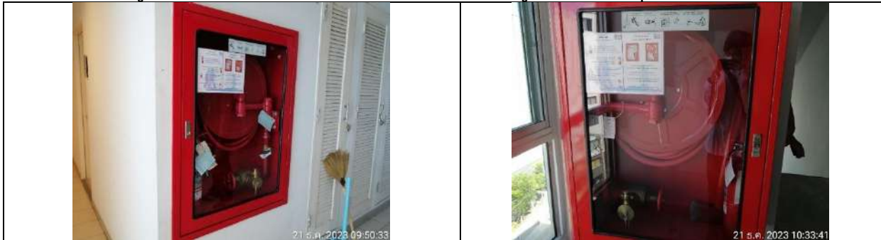
ระบบท่อเย็นและตู้เก็บสายฉีดน้ำดับเพลิง
